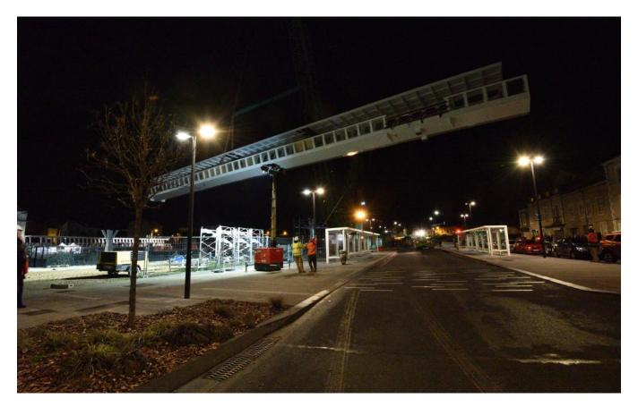
Sa fabrication a duré cinq mois, son montage trois mois, le long des voies SNCF. Le tronçon n°1 de la passerelle (55 mètres de long) s'est doucement élevé dans les airs avant de pivoter audessus du pôle d'échange multimodal pour rejoindre l'axe des deux piles destinées à le soutenir. © Crédit photo : Michel Faure
