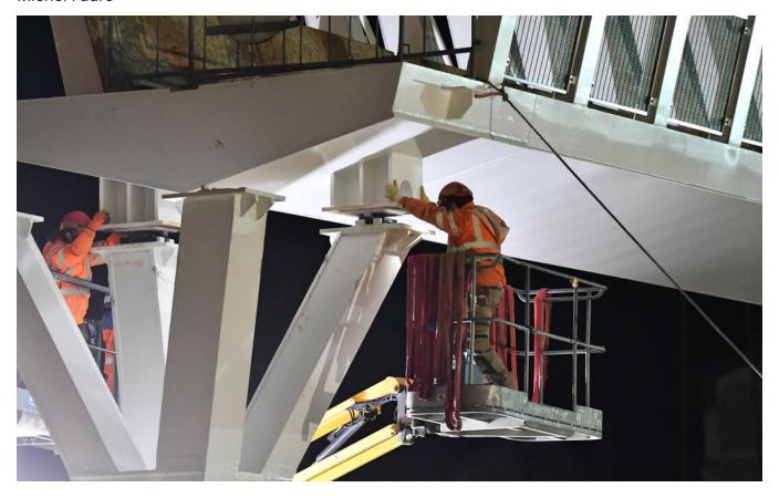
Calages à 7 mètres du sol pour l'ouvrage fabriqué et posé par l'entreprise Matière, dont le siège se trouve à Arpajon, dans le Cantal.
