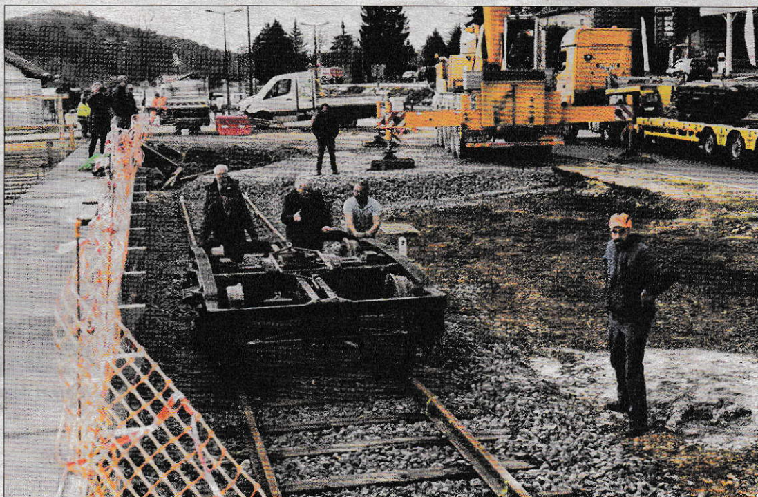
Grâce au travail des bénévoles, un tronçon de 30 mètres a été conçu pour accueillir la voiture qui servira de salle de restaurant. PHOTOS RÉMI PHILIPPON
